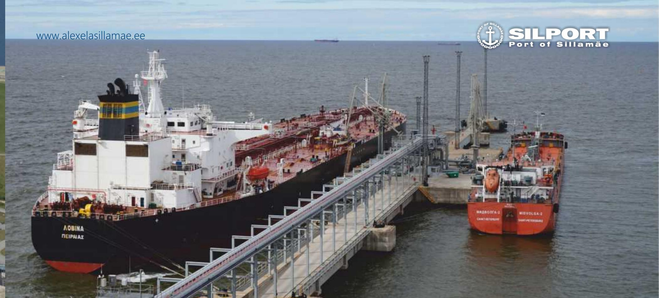
Alexela Sillamäe производит перегрузку и хранение светлых и темных нефтепродуктов, а также минеральных масел. Alexela Sillamäe располагается в свободной зоне первой категории Порты Силламэ и является одним из его операторов. Причалы терминала принимают танкера до 150 000 DWT с длиной до 275 м. Терминал гибкий: груз принимается с железнодорожных цистерн и танкеров, выдается на танкера, железнодорожные цистерны и автомашины. Благодаря использованию современного
