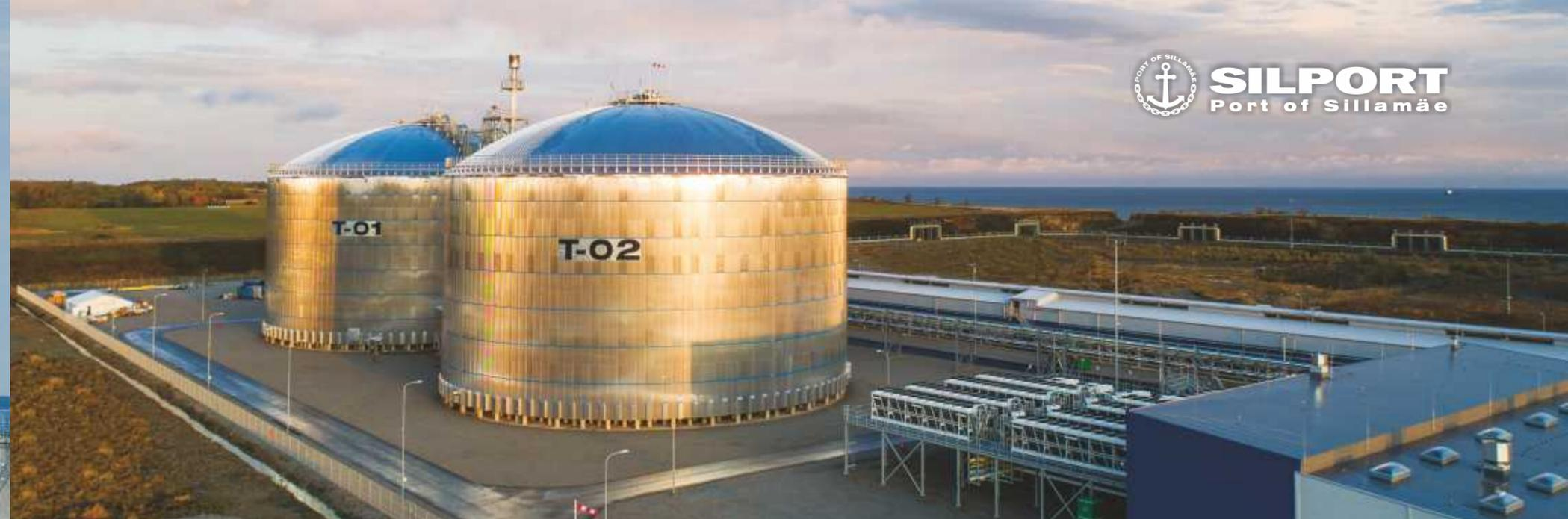
EuroChem Terminal Sillamäe – терминал по перевалке наливных химических и нефтехимических продуктов с резервуарным парком общей ёмкостью 44 000 м<sup>3</sup> и объёмом перевалки до 600 000 тонн в год, а также с резервуарным парком 60 000 м<sup>3</sup> для работы с аммиаком, объёмом до 1 000 000 тонн в год.
